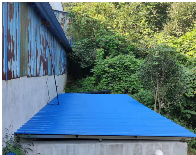
初期雨水收集池
