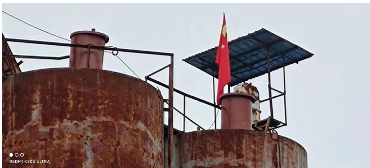
2 个 100T 产品料仓，滤芯除尘器
