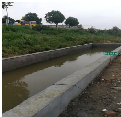
图 3-6 初期雨水收集池
