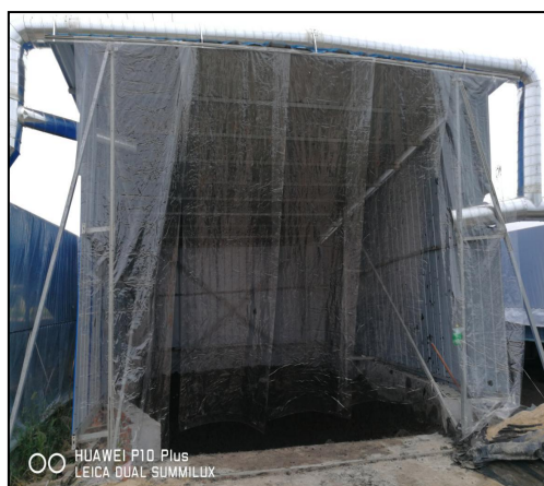
图1-9 污泥搅拌间废气密闭收集
