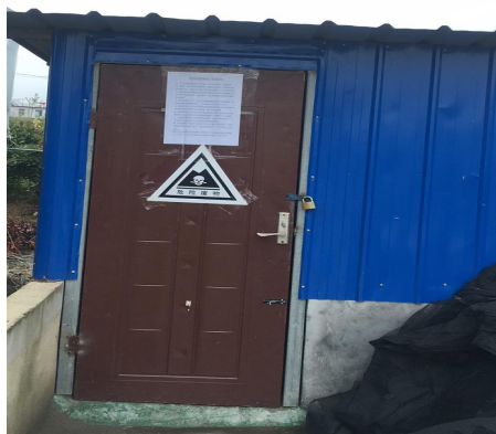
图 3-9 危险废物暂存库
