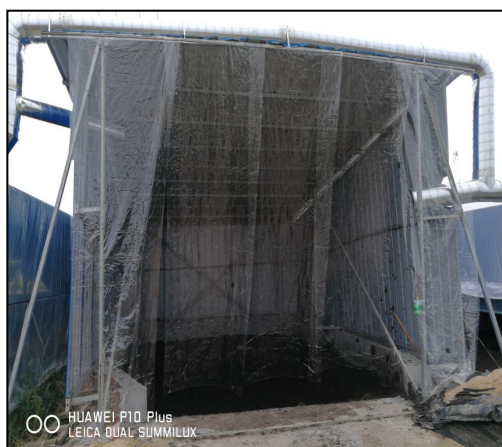
图 3-2 原料搅拌间废气收集管道、密闭设置
