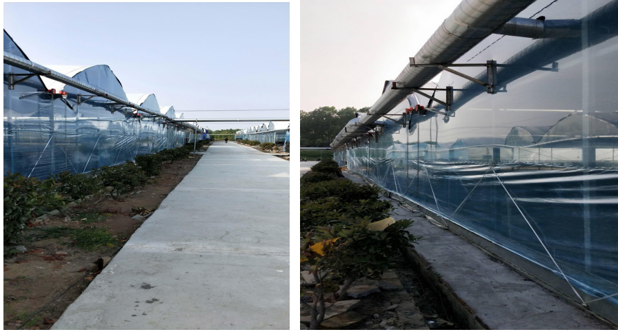
图1-5 土地硬化及雨水收集沟渠
