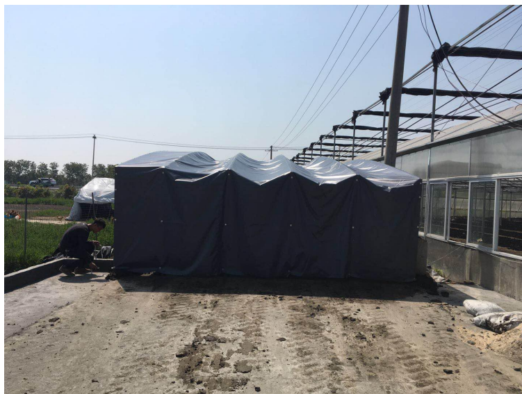
图 1-1 污泥暂存库整改后
