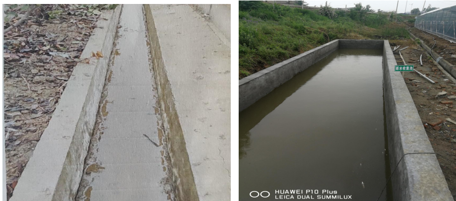
图1-6 雨水收集沟渠和雨水收集池
